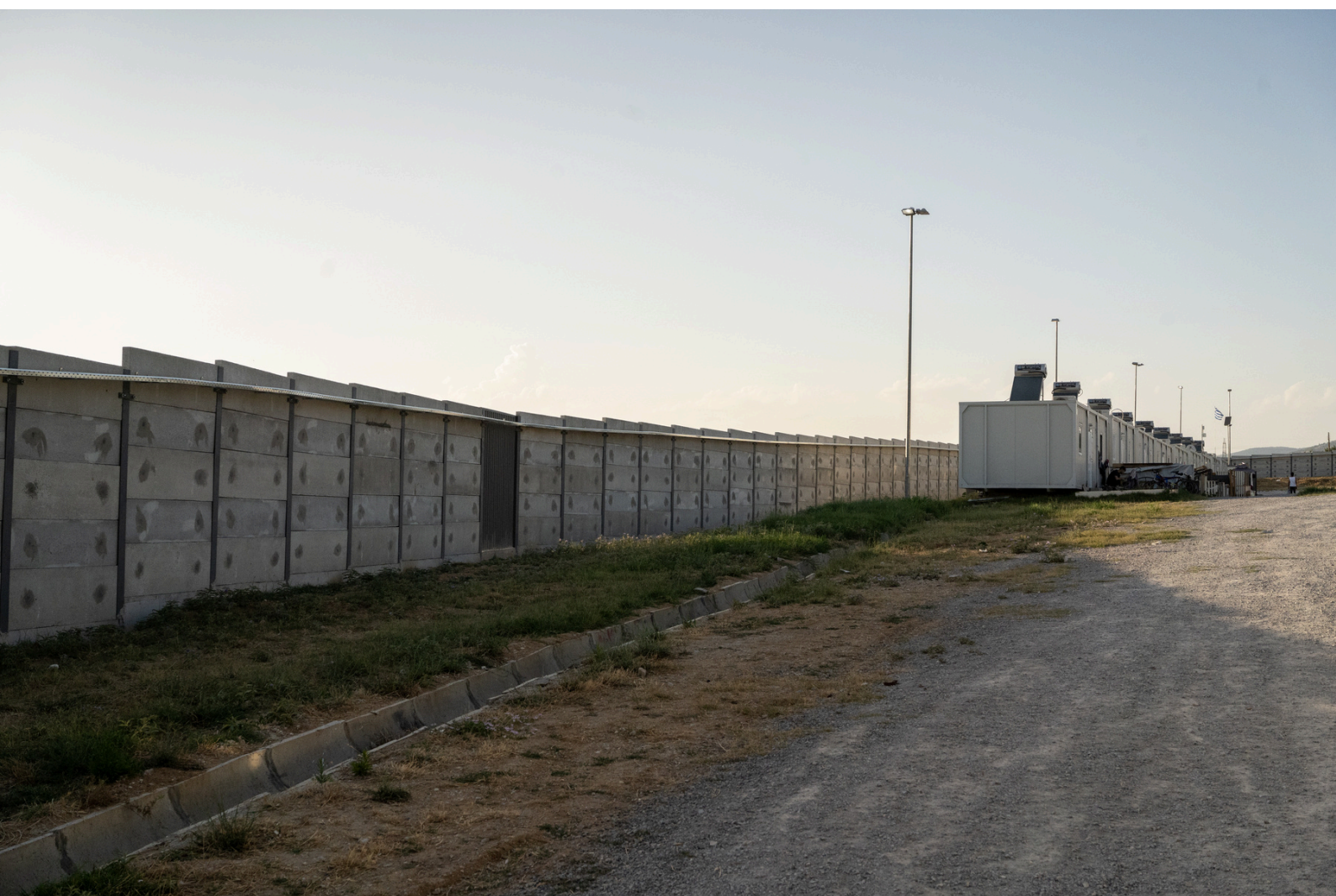
Camp de Diavata après la construction du mur d'enceinte, juillet 2021
